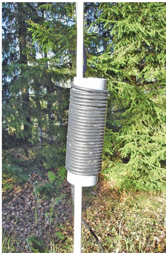
Foto 1.2.9.4. Jako výztuž spojení slouží plastové košíčky, ke kterým jsou konce kabelů přivázány stahovacími páskami.
