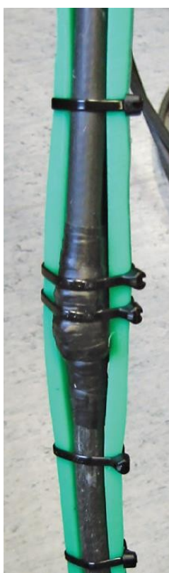
Foto 1.2.9.4. Jako výztuž spojení slouží plastové košíčky, ke kterým jsou konce kabelů přivázány stahovacími páskami.
